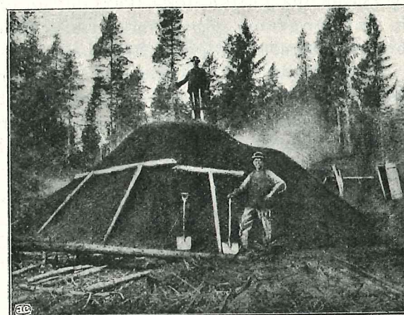
Fig. 3. Värmlandsmila under kolning.
